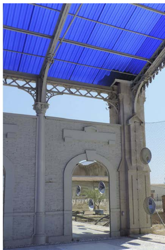
Figura 4. Izquierda. Medio Plano de fundaciones de fecha 3 de Diciembre de 1885. Detalle de la sección longitudinal y transversal de los grupos de pilotes de las columnas de fundición sobre las que apoyan las cerchas de la cubierta del andén. (Fragmento). Archivo Histórico Ferroviario. Derecha. Vista actual de una de las columnas de fundición.
