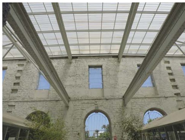
Figura 7. Izquierda. Detalle de la viga de hierro para los entramados horizontales del edificio de viajeros. Archivo Histórico Ferroviario. Signatura: A-0007-005. Derecha. Detalle de las vigas de hierro del cuerpo principal. Estado actual.
