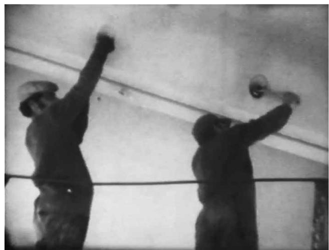
Figura 12. Operarios colocando pernos de anclaje en las piezas de cubierta. Fotograma del video *Industrialización en la construcción*.
