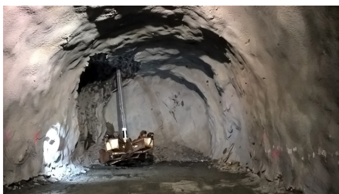
Figura 13. Ejecución de pozos subverticales mediante la técnica de raise boring
