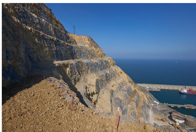
Figura 15. Aspecto final de los taludes de la ladera estabilizada
