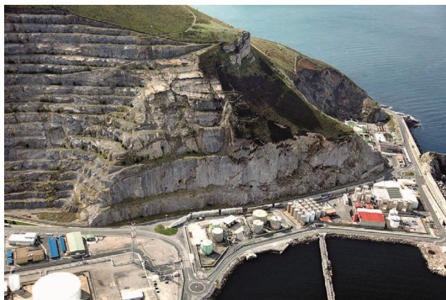
Figura 1. Vista aérea del sector inestable en la antigua cantera de Punta Lucero, junto a instalaciones portuarias situadas en la plataforma inferior (2)
