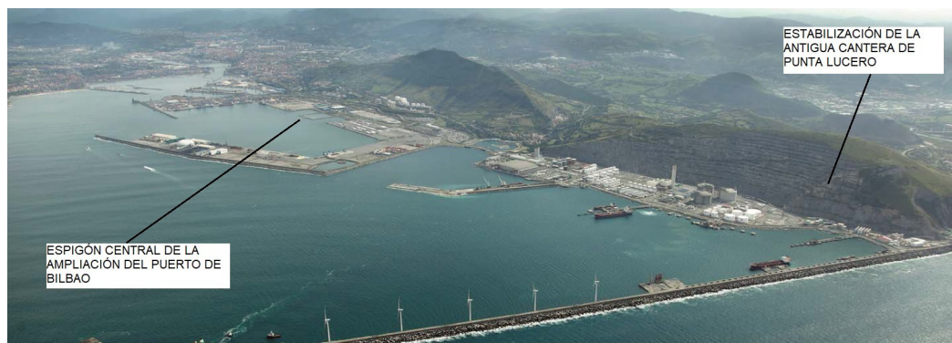
Figura 8. Localización de las dos prestaciones contractuales dentro de las instalaciones de la Autoridad Portuaria (2). Obras de estabilización de ladera (dcha.) y obras de Espigón Central de la ampliación del Puerto de Bilbao (izda.)
