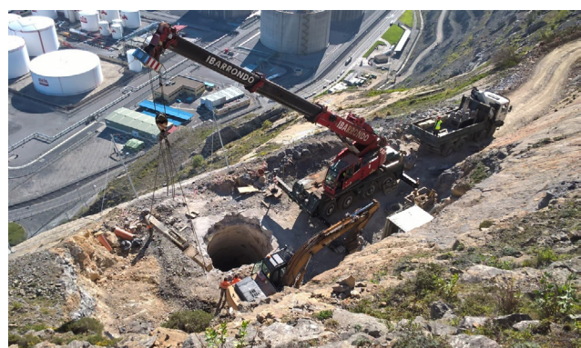
Figura 13. Ejecución de pozos subverticales mediante la técnica de raise boring
