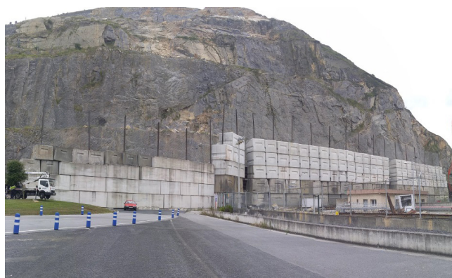
Figura 5. Muro de bloques en el pie del talud para controlar desprendimientos ocasionales
