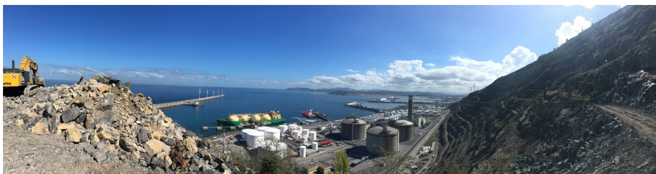
Figura 22. Panorámica de las instalaciones portuarias desde las obras de la ladera
