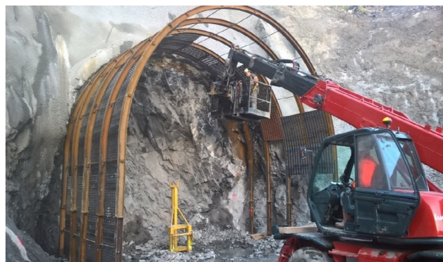
Figura 9. Emboquille de túnel
