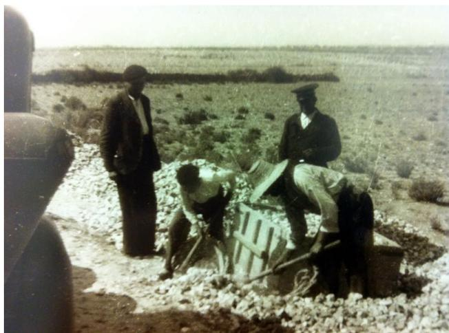
Figura 9. Medición de la piedra partida a disponer en la carretera en cajón de 1 m<sup>3</sup>. Década de 1950. Fotografía: Vesalio Manso de Pedro.
