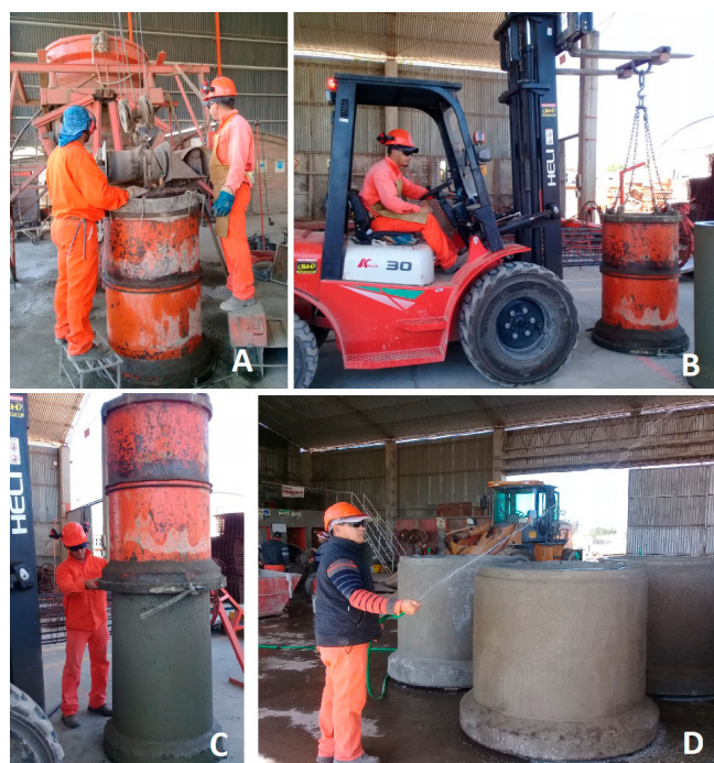
Figura 2. A) Moldeo; B) Transporte hasta el lugar de almacenamiento; C) Desmolde; D) Humedecimiento de la superficie de los tubos.
