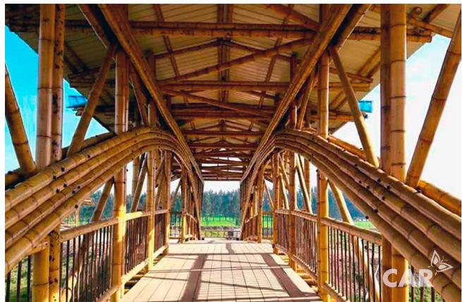
Figura 11. Detalle del interior del Puente de Guadua. Fuente: Corporación Autónoma Regional de Cundinamarca.
