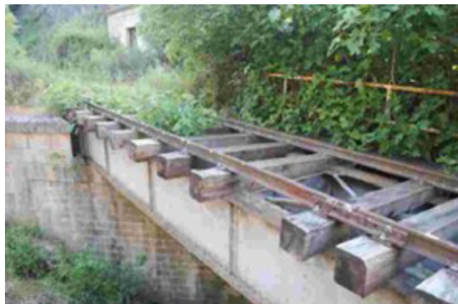
Figura 9. Puente sobre el arroyo Pingallo. Puente número 1.
