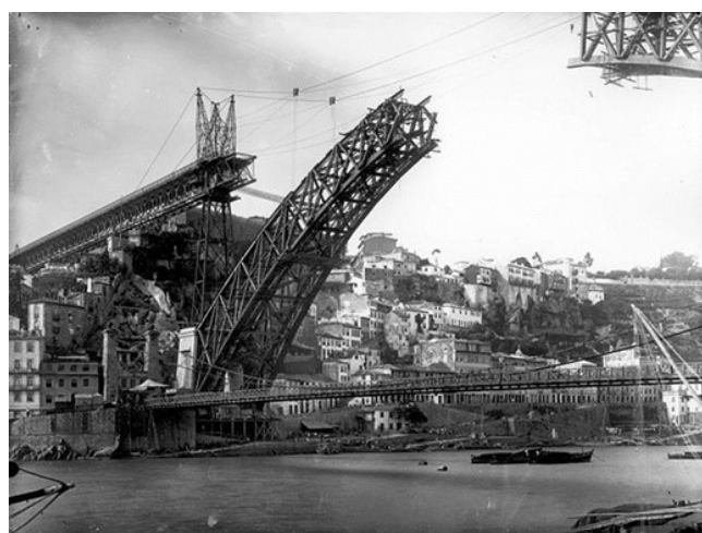
Figura 2. Construcción del arco del Puente Luis I de Oporto. Fotografía de Emilio Biel (EB), 1838-1915.
