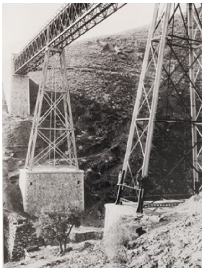
Figura 15. Puente Arroyo Lugar, protección pilas metálicas(EB).
