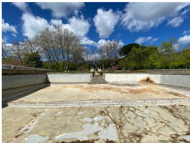
Figura 17. Estanque alto de la Casita del Príncipe, vacío; abril de 2022. Se precian claramente las irregularidades del fondo, y los dos niveles. Fotografía: los autores.
