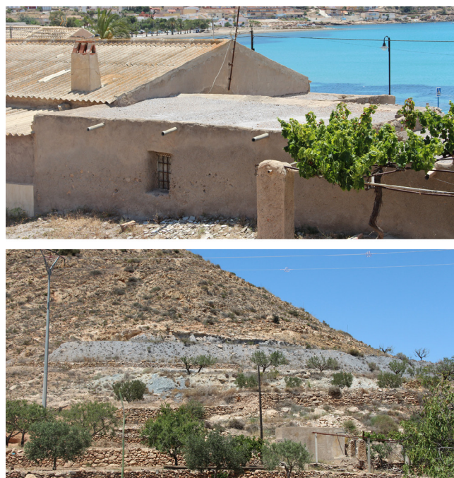
Figura 3. Lagueneta (arriba) y edificación con cubierta plana de láguena (abajo) en La Azohía. (Autores).
