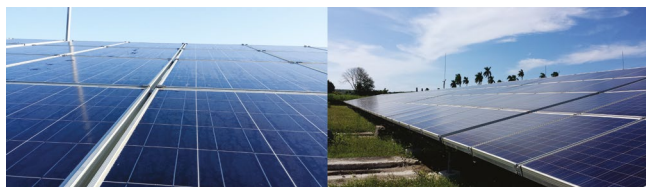
Figura 6. Casos típicos de parques fotovoltaicos sin separación entre columnas.
