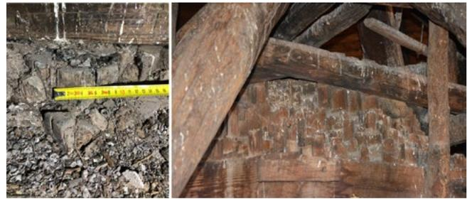
Figura 18. Fotografías del trasdós del artesanado empleadas para la reconstrucción de las adarajas.
