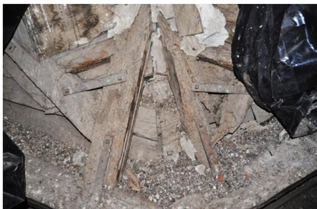
Figura 10. Fotografía del tradós del artesonado. Presencia de pletinas de hierro forjado.
