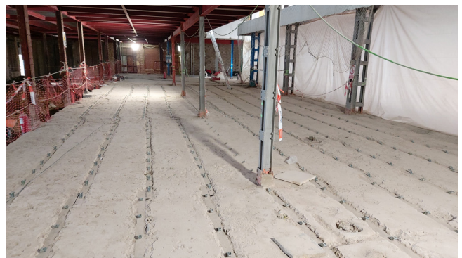
Figura 25. Conectores en refuerzo de forjado de planta baja.
