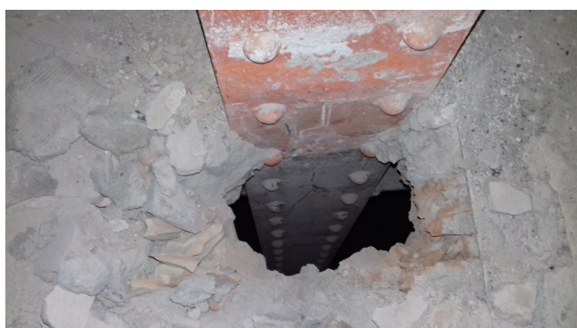
Figura 8. Cata en forjado para confirmar continuidad de soportes.
