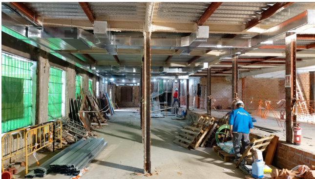
Figura 37. Instalación de conductos en falso techo.
