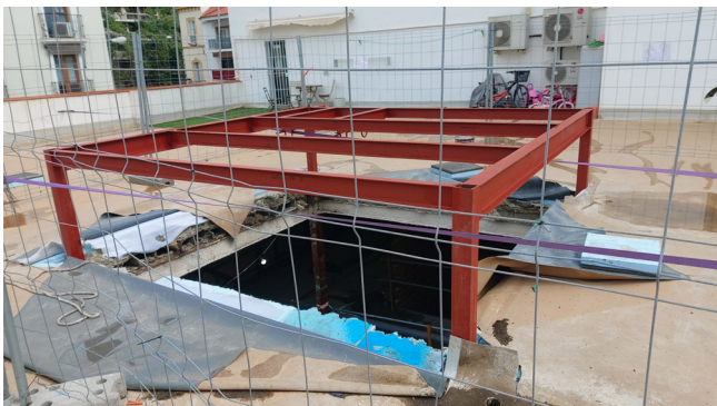
Figura 33. Recreido de soportes para forjado en cubierta.
