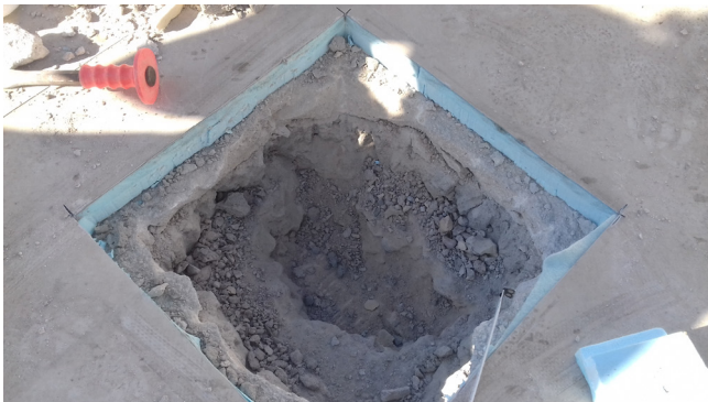
Figura 12. Cata en cubierta para confirmar sección constructiva.
