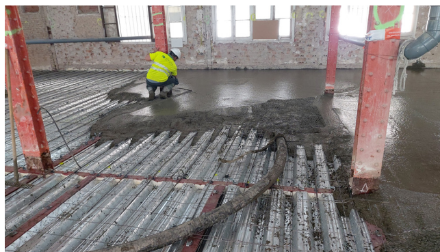
Figura 29. Comprobación de conectores, negativos y hormigonado.
