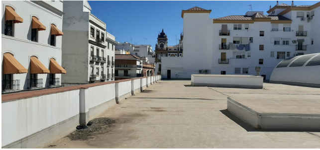
Figura 11. Cubierta existente en el ámbito de actuación.
