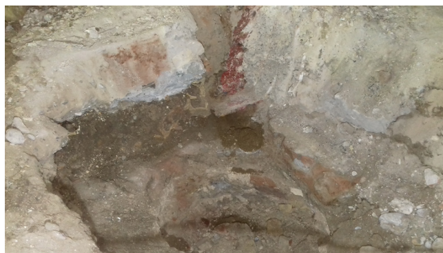
Figura 9. Cata en apoyo de soporte metálico sobre muro antiguo.
