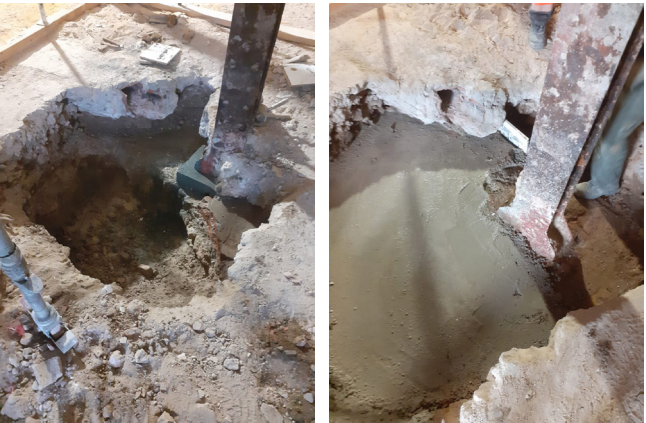
Figura 22. Recalce en zapata existente.
