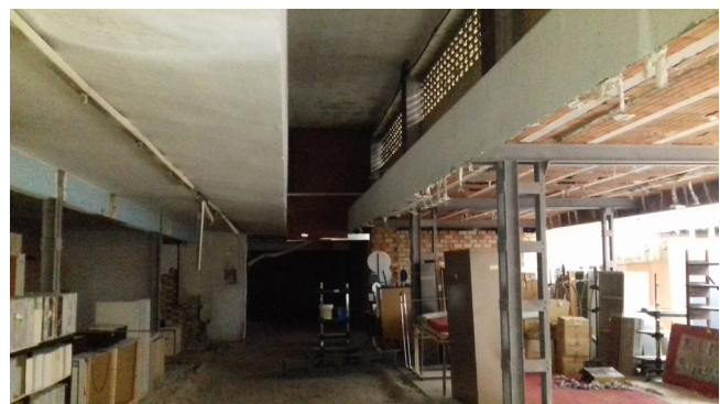
Figura 6. Estado de la planta baja como trastero.
