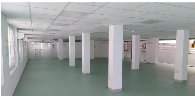
Figura 39. Nuevas luminarias tipo LED en interiores.
