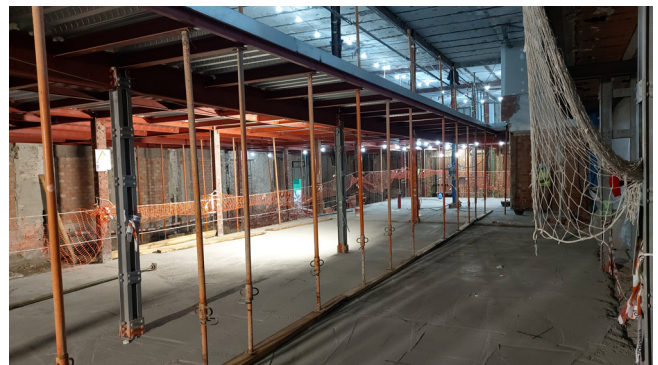
Figura 26. Hormigonado de capa de compresión en planta baja.
