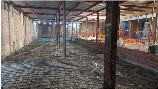
Figura 32. Colocación de doble armadura para solera arriostrante.
