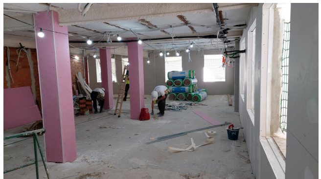
Figura 34. Protección de pilares y jácenas contra el fuego.
