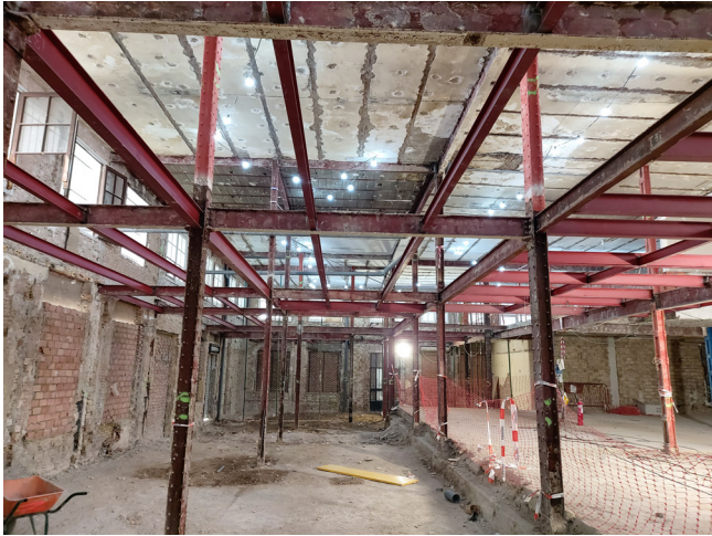
Figura 23. Demolición de forjado de planta primera.
