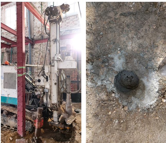
Figura 24. Mejora del terreno mediante micropilotaje.
