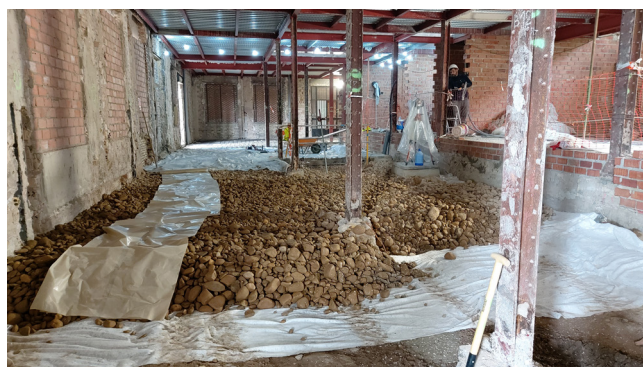
Figura 31. Encachado de bolos de grava en planta baja.
