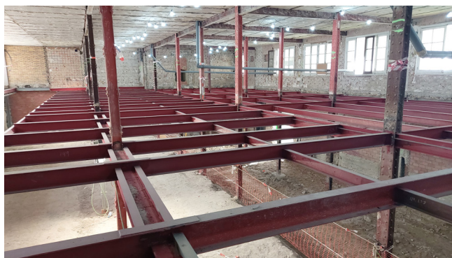
Figura 27. Replanteo de jácenas y viguetas.
