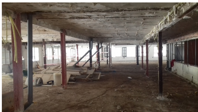
Figura 7. Vista de la estructura porticada.
