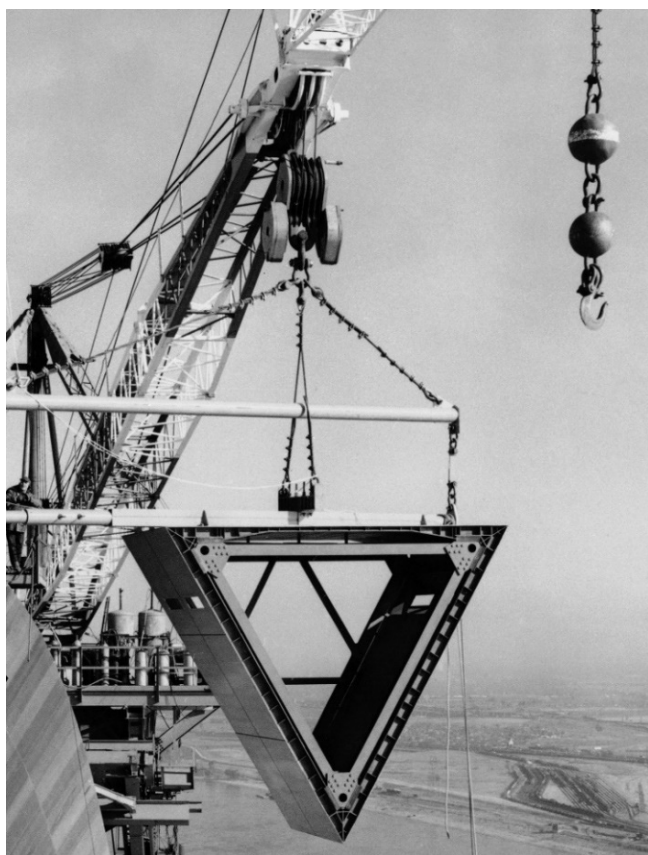
Figura 8. Proceso de construcción Gateway. Archivo Fernando Cassinello
