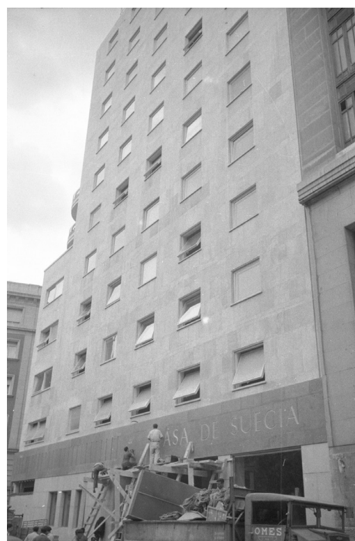
Figura 10. Trabajos en la fachada de la Casa de Suecia. Madrid, 1956. Fotog. Martín Santos Yubero. Archivo Regional de la Comunidad de Madrid.
