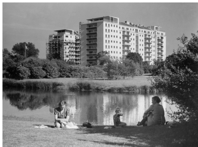
Figura 1. Ribershus en construcción. Vista desde Öresundsparken, Malmö, 1937-1938. Colección del constructor Eric Sigfrid Persson, Archivos de la Ciudad de Malmö.
