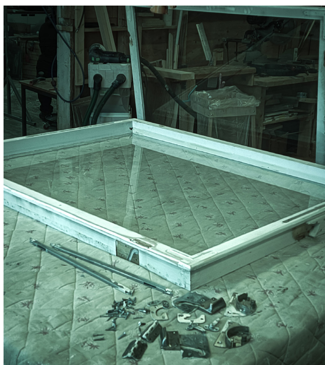
Figura 13. Ventana en perspectiva en reparación. Fotografía actual cedida por Byggnadsvård Robertsfors, Malmö.
