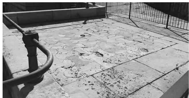
Figura 12. Bóveda plana en la presa de Pontón de la Oliva.
