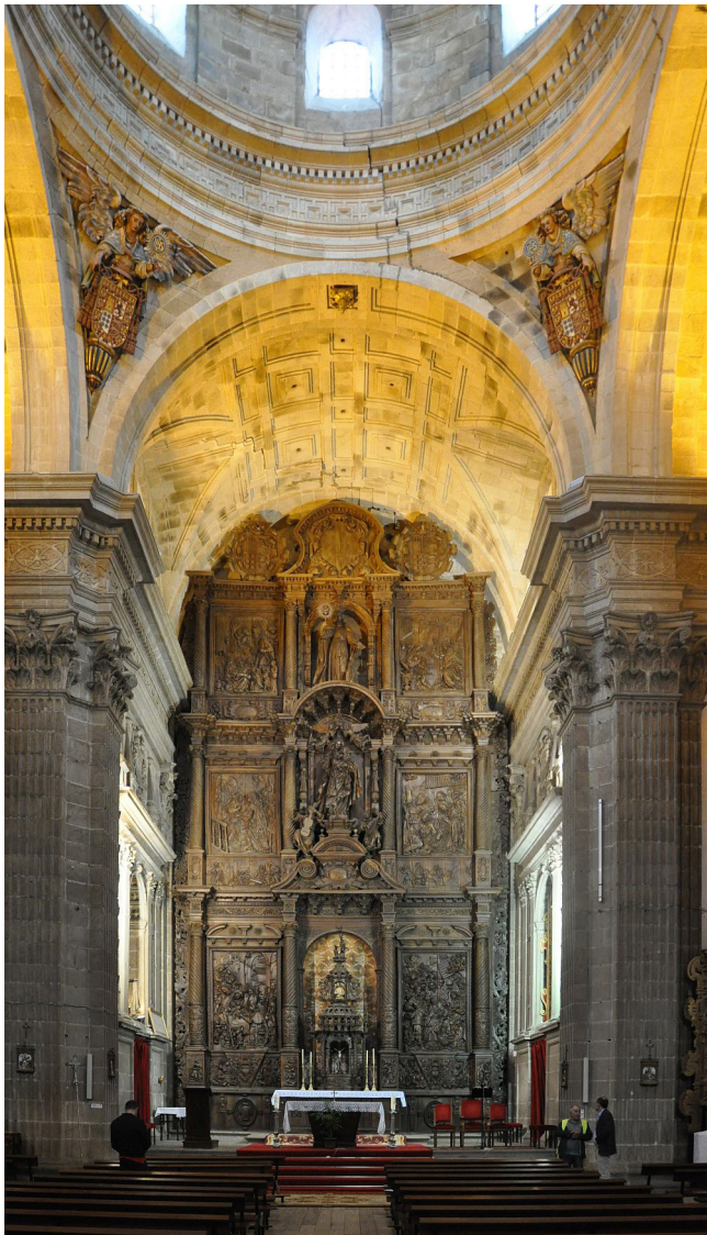
Figura 3. Altar Mayor (antes de las obras).
