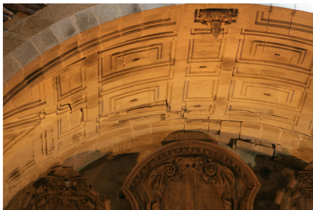
Figura 4. Lesiones en la bóveda del Altar Mayor (antes de las obras).
