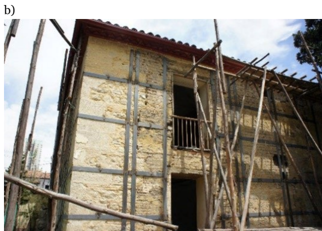
Figura 1. a) Esquema de reforzamiento con placas de acero en un muro de dos niveles de una edificación en tierra, b) fotografía de una edificación patrimonial en tierra en proceso de reforzamiento con placas de acero (fuente: los autores).
