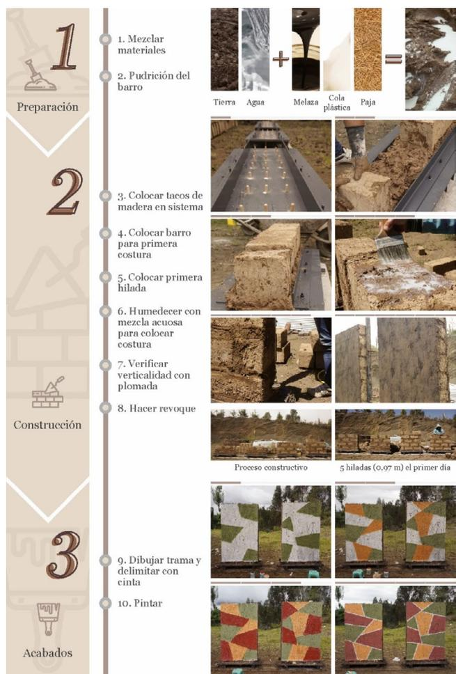
Figura 2. Proceso constructivo del refuerzo.
