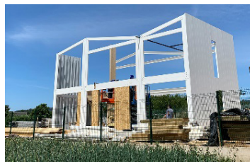
Figura 7. Montaje marcos PB y muros.
