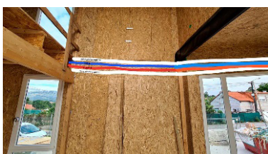
Figura 12. Replanteo instalaciones de fontanería electricidad y teleco.
