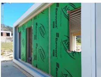
Figura 9. Colocación lámina impermeable en fachada hastial.
