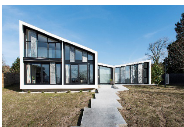
Figura 22. Boiro CSH. Acabado exterior.
