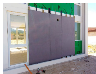
Figura 20. Instalación acabado de fachada.
