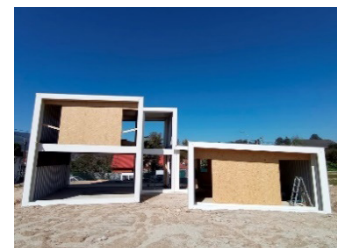
Figura 8. Estructura y cubierta completas.
