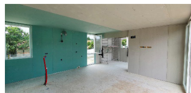
Figura 17. Colocación placas de yeso laminado.
