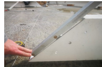
Figura 5. Replanteo marcos estruct.
