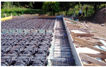
Figura 3. Cimentación armados.
