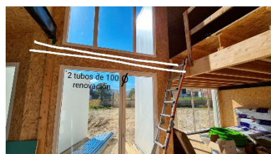
Figura 13. Replanteo conductos de climatización y ventilación.
