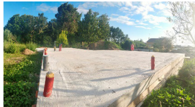
Figura 4. Cimentación solera ventilada.
