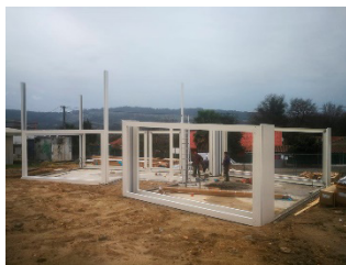
Figura 6. Montaje marcos estruct. PB.
