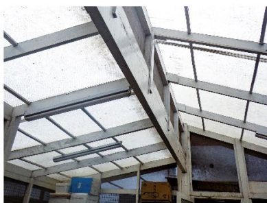
Techo del invernadero
