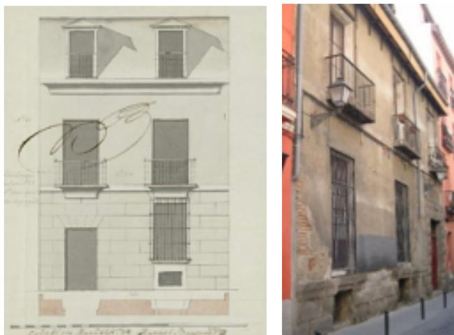
Figura 7. Corralas en c/del Oso: a) n°13, alzado original [2+b] (AVM, 1-47-59, 1772); y b) n°19 [2-3/3], estado actual (alzado desconocido).
