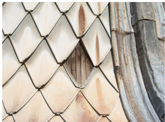
Figura 11. Detalle de la cubierta de tejas de zinc de la cúpula de la Colegiata de Xàtiva (Valencia). Luis Cortés
