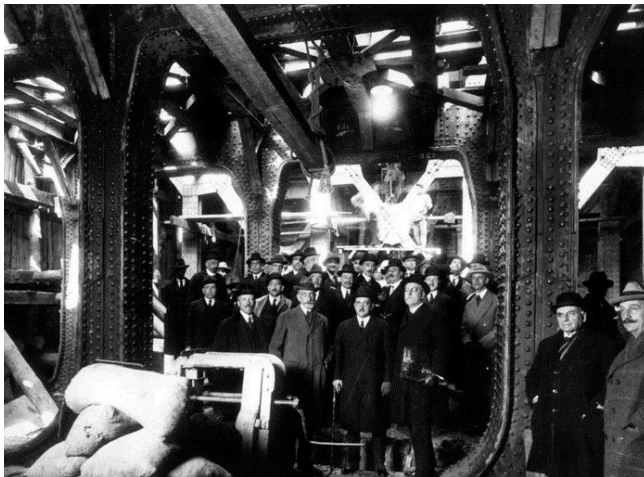
Figura 4. Ejemplos Vigas Vierendeel. Visita de las autoridades a las obras del Ferrocarril Metropolitano Transversal de Barcelona (1924). Fuente: (7)
