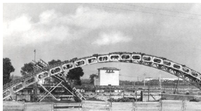
Figura 7. Modelo a escala de un arco realizado con elementos prefabricados formando una viga Vierendeel. Fuente: (20)
