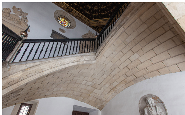
Figura 6. Bóveda que sustenta el segundo y tercer tramo de la escalera. Imagen de los autores
