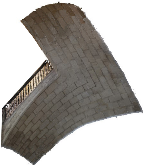
Figura 7. Nube de puntos densa obtenida mediante fotogrametría. Imagen de los autores
