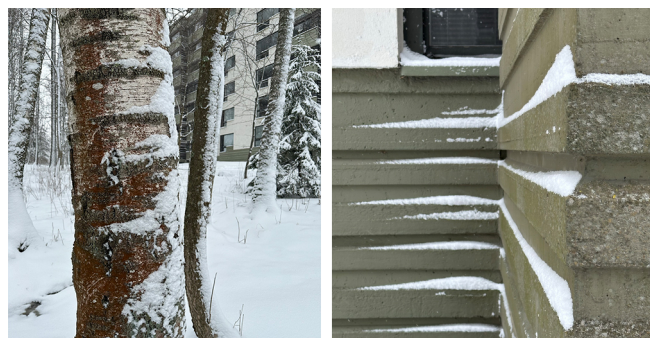
Figura 16. Izq.: Fotografía del entorno de Suvikumpu nevado. Dcha.: Detalle de la nieve posada en las hendiduras del hormigón de fachada. 2022 [Fuente: Elaboración propia]
