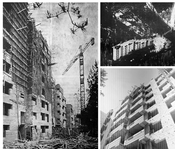
Figura 9. Fotografías del proyecto durante su construcción. Desencofrado de los muros estructurales de hormigón de fachada, ca. 1968 [Fuente: MFA]
