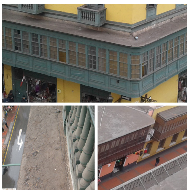
Figura 19. Capa de cobertura de tierra en los techos de los balcones peruanos (Foto de los autores).
