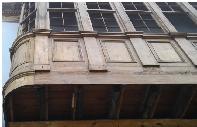
Figura 15. Vista de las piezas realizadas en serie para formar la decoración de un balcón de finales del siglo XVIII y fijadas con clavos (Foto de los autores).
