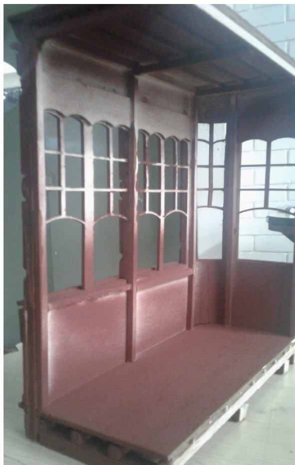
Figura 16. Maqueta de balcón de finales del siglo XVIII mostrando un corte transversal con las piezas de madera que lo componen (Foto de los autores).
