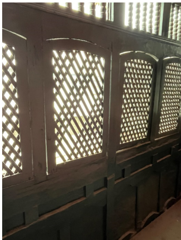
Figura 10. Celosías con sistema de apertura proyectante hacia el exterior, cuyo giro se produce en la parte superior del vano (Foto de los autores).
