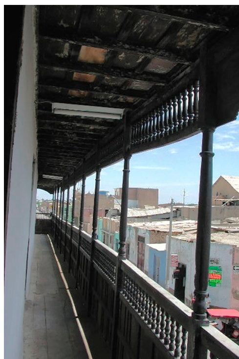
Figura 2. Balcón “abierto” en Lambayeque con las características de los iniciales balcones que se construyeron en el siglo XVI (Foto de los autores).
