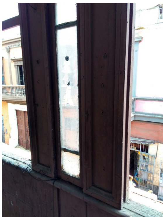
Figura 18. Detalle del canal central tallado en el pie derecho para deslizar la ventana (Foto de los autores).
