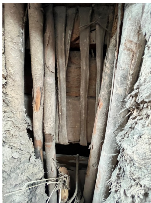
Figura 9. Tiras de piel en las uniones de las vigas que forman la solera superior (Foto de los autores).
