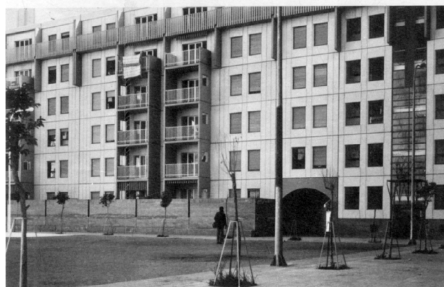
Figura 4. Conjunto de Cerdanyola, MBM: fachada y detalle de panel. Arquitecturas Bis 16
