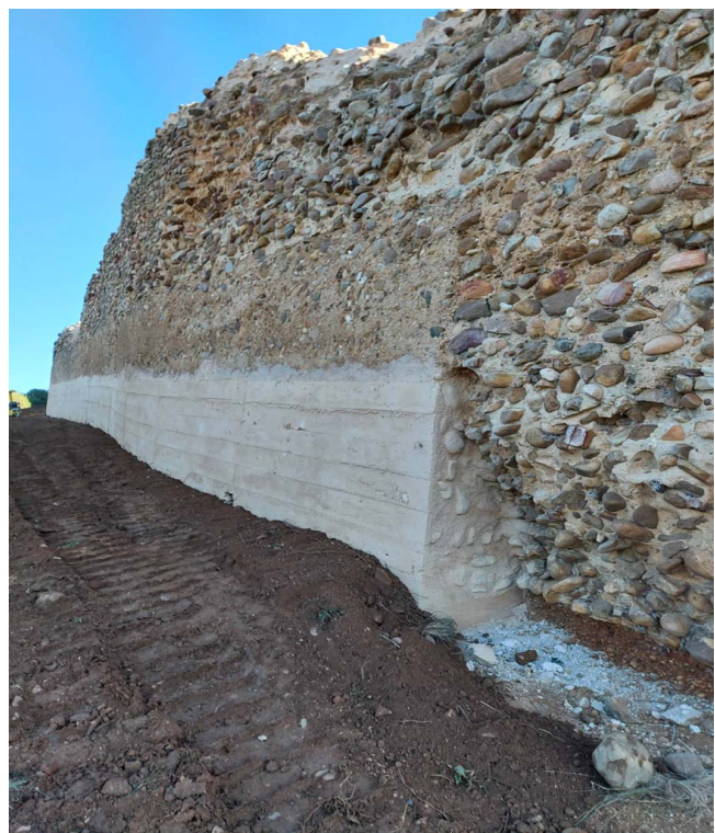
Figura 16. Vista general del exterior mostrando el remate de la reintegración en la base
