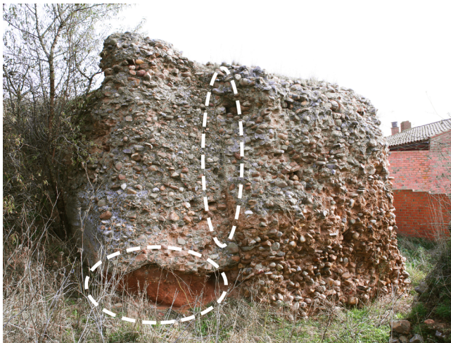
Figura 6. Detalle de la puerta que muestra el lienzo de muralla cimentado sobre la estructura en tierra y la junta vertical en contacto con el muro ortogonal
