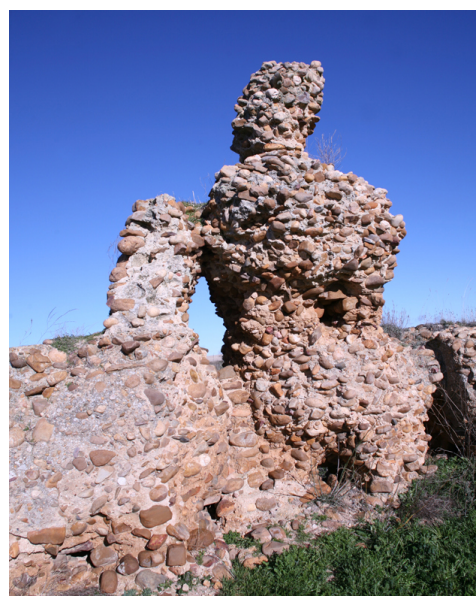
Figura 9. Foto de la torre mostrando pérdida de material, elementos inestables y coronaciones en mal estado
