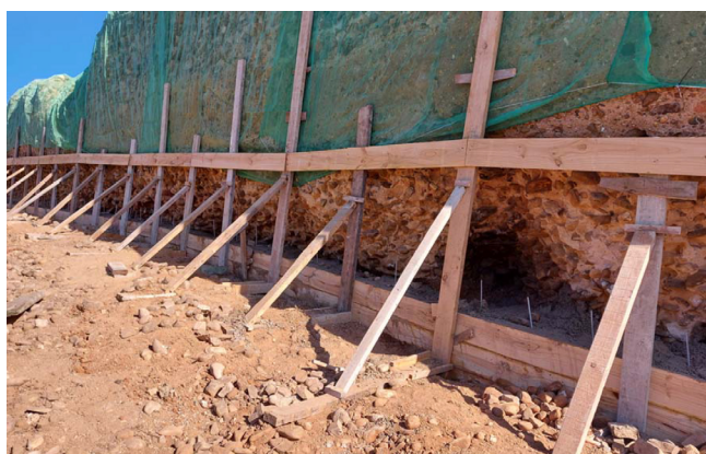
Figura 12. Preparación del terreno y colocación de postes y puntales del encofrado
