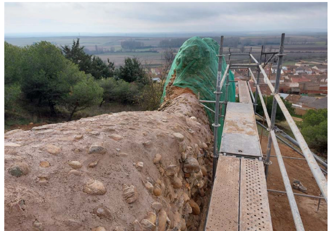
Figura 15. Trabajos de remate de las coronaciones de los muros
