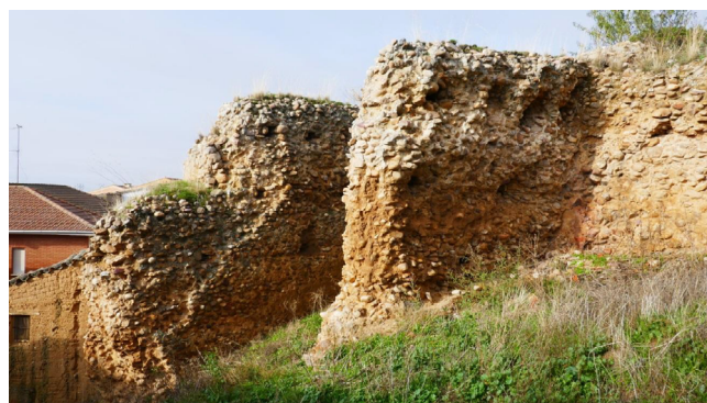
Figura 5. Muros de tapia de cal y canto de la puerta construidos después del lienzo de la muralla
