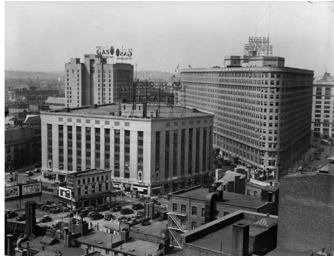
Figura 7. Motor Mart Garage , 1927, diseñado por Ralph Harrington Doane. (Cortesía de Boston Public Library.)
