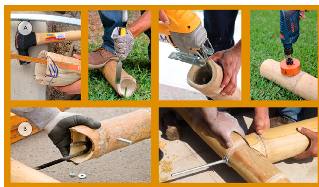
Figura 5. Ilustración de procesos de uniones con bambú - A: Diferentes herramientas para el corte tipo boca de Pescado, B: Fijación con perno tensor (18)
