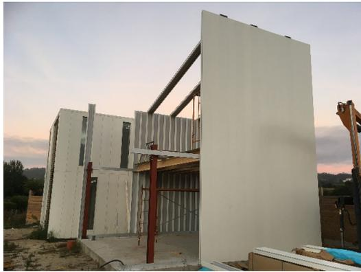
**Figura 5.** Montaje del prototipo con pilares metálicos auxiliares.
