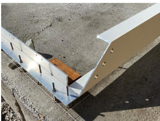
Figura 14. Encuentro entre solera y cerramiento Ls80\*8, varillas roscadas y tuercas a ambos lados
