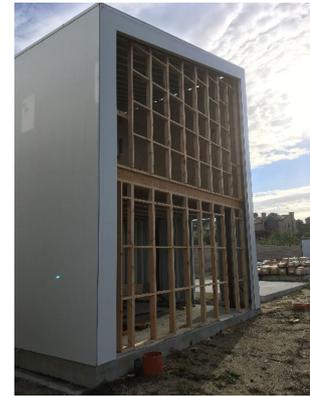
**Figuras 6 y 7.** Colocación de marcos de refuerzo de aluminio soldado en la fachada a dos aguas, y entramado de madera tipo ballonframe, que actúa como una pared de arriostramiento en la unidad 2 del prototipo.
