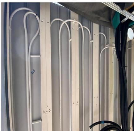
Figura 9. Tubos de polipropileno en circuito de colector solar.
