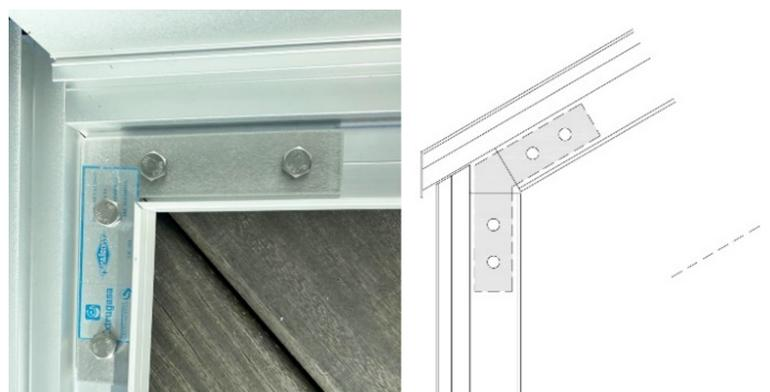
Figura 15. Detalle de los nuevos diseños de pletina para la unión de fachada y cubierta.
