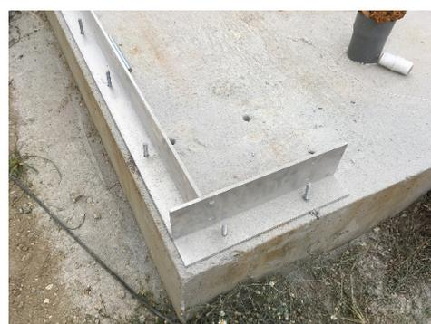
Figura 4. Perfil "L" encuentro entre solera y fachada portante en el primer montaje experimental.
