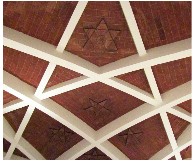
Figura 10. Intradós de la bóveda de la esquina noreste de la planta principal, a base de arcos de medio pie de ladrillo (al aparejo visto de rasilla se añaden estrellas de cinco y seis puntas) [fotogr. J. Fakhoury]
