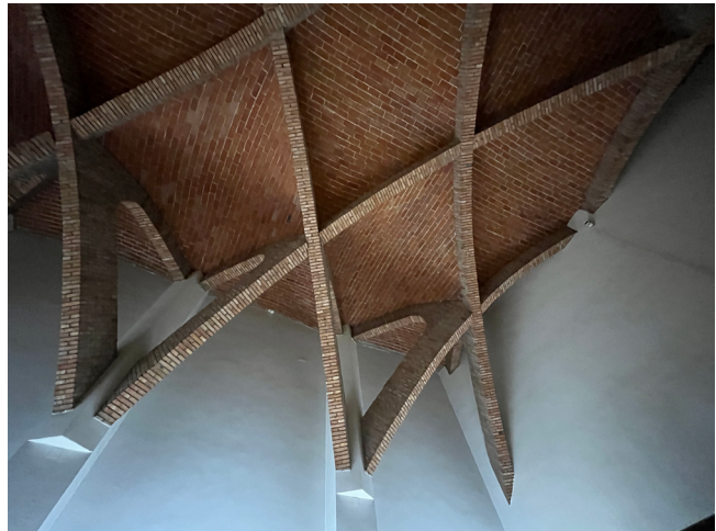
Figura 23. Bóveda del Salón de Honor. Detalle del encuentro de los arcos con los contrafuertes de la pared lateral y el remate de la bóveda en la pared frontal [fotogr. J. G. Mosteiro]
