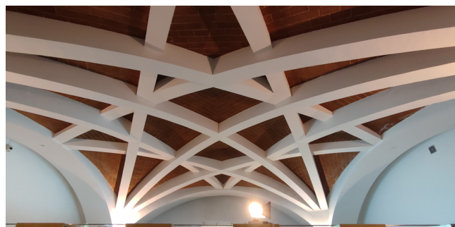
Figura 8. La misma bóveda de la Biblioteca, ya cerrada con los plementos de bóveda tabicada de sencillado visto (independientes entre sí) y con los arcos revestidos. Se observa el arranque de los tres arcos en las esquinas, sobre saledizo de ladrillo macizo; también, el entrecruzado de los arcos, a distintas alturas [fotogr. J. Fakhoury]
