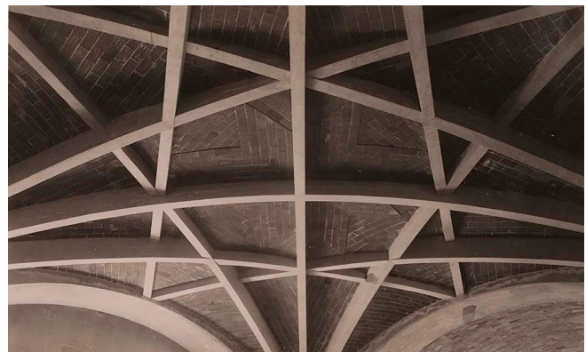
Figura 11. Intradós de la bóveda de la esquina noroeste de la planta principal, con el mismo trazado de arcos que la anterior. El efecto plástico que producen los plementos vistos se refuerza con la hoja de rasilla añadida, en forma de estrella de ocho puntas (concéntrica con la intersección de los arcos diagonales y aparejada según la dirección de éstos) [ETSAM_Fondo LMB]
