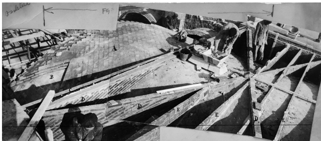
Figura 3. Proceso constructivo de las bóvedas continuas del Museo de América. Se aprecia el sencillado y tres vueltas de doblado (A); el apoyo escalonado preparado para el arranque del luneto, sobre el sencillado continuo (B) (para ser eliminada la parte correspondiente al luneto tras la construcción de éste); el tirante metálico (C); refuerzos del trasdós (D) y tabiquillos para formación de tablero del suelo (E). (Montaje fotográfico preparatorio —no llegado a publicar— para el tratado Bóvedas tabicadas [ETSAM_Fondo LMB])
