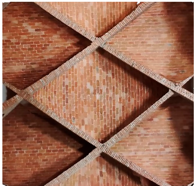
Figura 24. Ortofoto de la parte central de la bóveda, en que se aprecia el aparejo —longitudinal y transversal— de los diferentes plementos [ortofoto J. Fakhoury]
