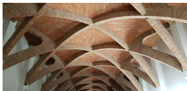
Figura 29. Vista general de la bóveda del Salón de Honor [fotogr. J. G. Mosteiro]
