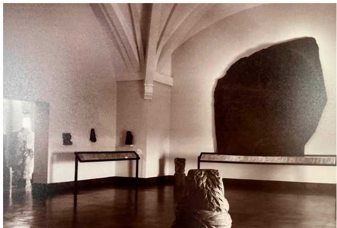
Figura 18. Sala de esquina del piso superior, con la museografía inicial (ca. 1965). Se observa el arranque de los arcos diagonales, a cota inferior a los demás, mediante mensulilla [Museo de América]
