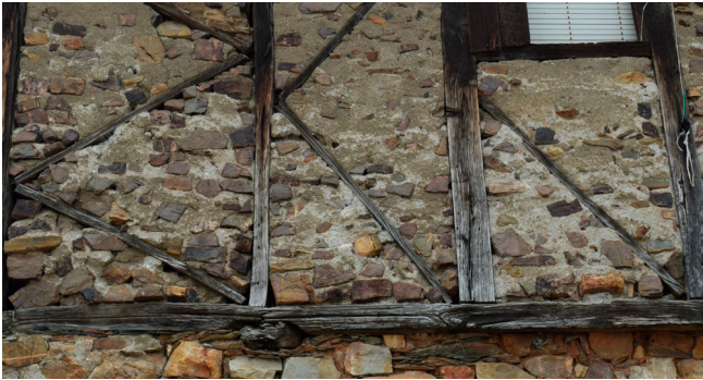
Figura 12. Muro en Rodanillo (León), en El Bierzo
