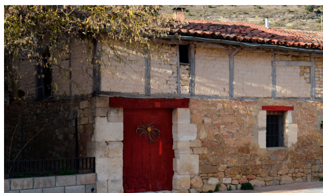
Figura 21. Muro en Markinez (Álava), en la Montaña Alavesa
