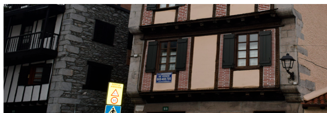
Figura 27. Muro en Lesaka (Navarra), en los Montes Navarros
