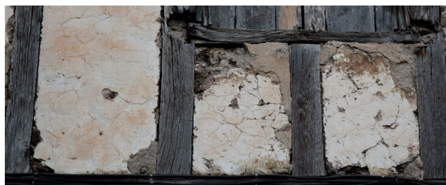
Figura 28. Muro en Lesaka (Navarra), en los Montes Navarros
