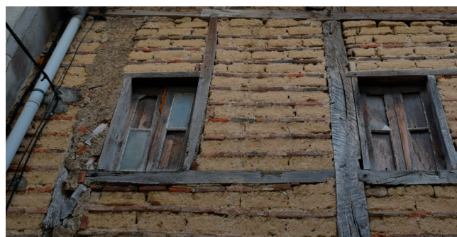
Figura 30. Muro en Treviño (Burgos), en el Condado de Treviño
