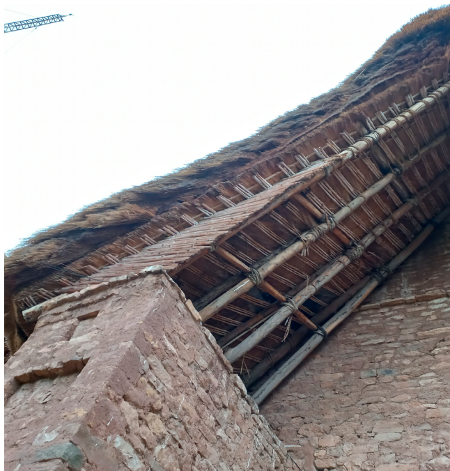
Figura 11. Pares y contrapares que forman una sección triangular en el alero, revestida con caña partida (foto de los autores)
