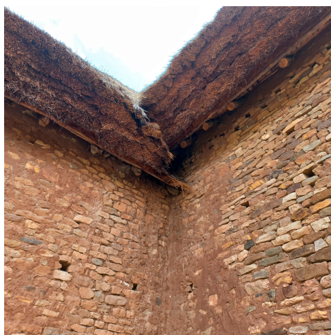
Figura 12. Lima hoya y manojos de paja colocados en tres estratos, sobre las correas de caña (foto de los autores)
