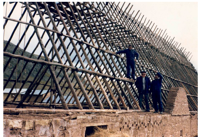
Figura 9. Estructura de rollizos durante la reconstrucción parcial de la cubierta luego del incendio. El largo de los pares fue recortado luego de su colocación (foto de Sabino Blanco)
