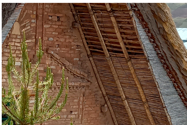
Figura 16. Ménsulas de piedras en los hastiales donde se fija la armadura a la fábrica mediante cuerdas (foto de los autores)
