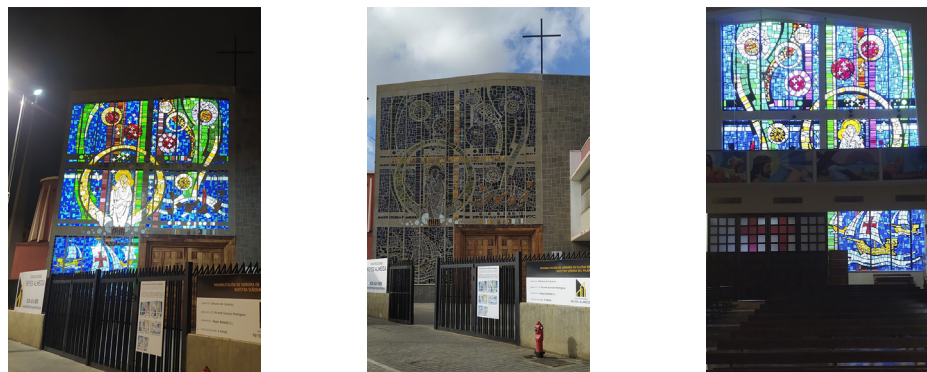
Figura 18. Fachada de la vidriera reformada
