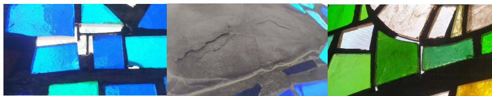
Figura 17. Estado de la vidriera previo a la reforma
