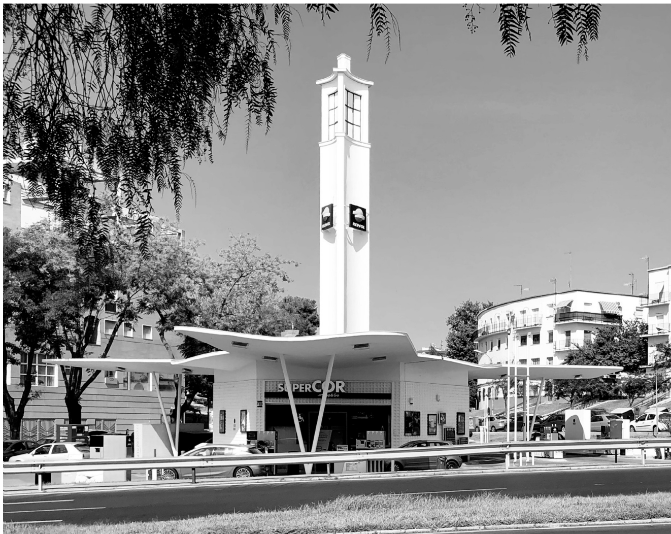
Figura 1. Estaci n de Servicio av. alcalde Federico Molina, Huelva (antigua CAMPESA, 1955-1959). Arquitecto Alejandro Herrero Ayll n (Autor a propia)
