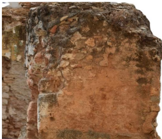
Figura 6. Huellas de la escalera en el paramento norte de la plataforma de la noria. Fuente: Informe de restitución de la noria elaborado por A. Jiménez (4)
