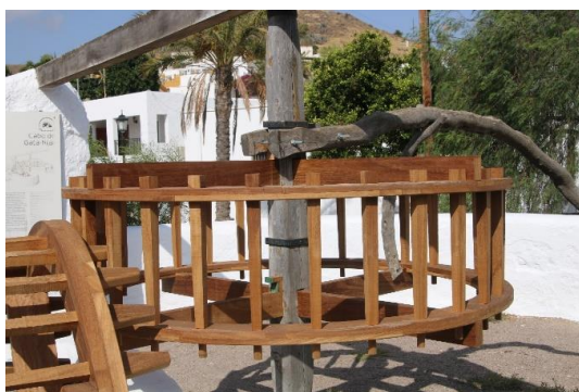
Figura 20. Rueda de aire en la noria restaurada en Pozo de los Frailes (Almería). Obsérvese la configuración de los dientes que sobresalen en sus anillos
