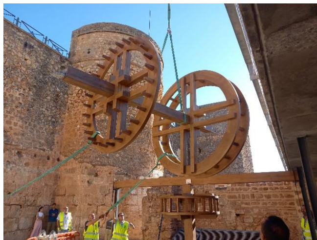
Figura 27. Izado de la viga principal con la rueda de la puntería y la rueda de agua. Fuente: Juan Martín
