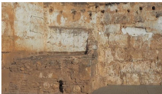
Figura 3. Restos de la cimentación de la antigua alberca
