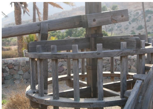
Figura 24. Pilar central y rueda de aire en la noria restaurada en Rodalquilar (Almería). Obsérvese el modo en que se resuelve la unión entre el pilar y la rueda. En esta noria, la inserción se encuentra a la altura de los largueros superiores. En el caso de Niebla, el hueco está en los largueros inferiores
