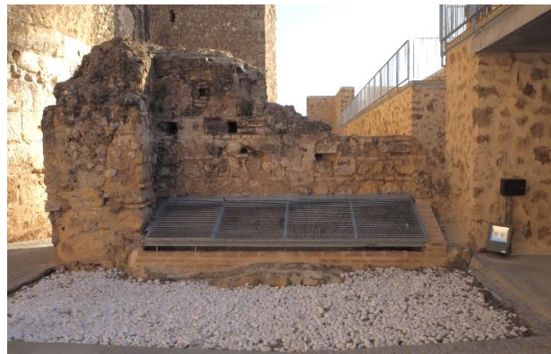
Figura 4. Imagen del pozo adosado a la barbacana. El pozo está protegido actualmente por una rejilla tramex galvanizada
