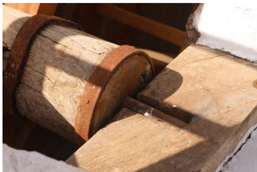
Figura 22. Ejemplo de cojinete de madera donde se introduce el perno de una viga circular para su giro. Noria restaurada en Pozo de los Frailes (Almería)
