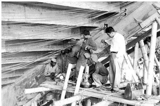
Figura 9. Pase de los cables de tensionamiento por los agujeros previstos en la parte baja de cada una de las vigas radiales. Fuente: (41).
