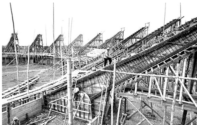
Figura 7. Armado de las vigas radiales en la plaza de toros de Cali. Fuente: (41)
