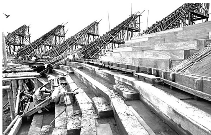
Figura 8. Fundición de las graderías simultáneamente con las vigas radiales. Fuente: (41).
