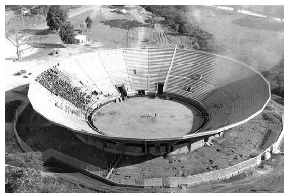
Figura 12. Aspecto final de la plaza de toros de Cali, en 1957, durante la prueba de carga efectuada en uno de los gajos estructurales. Fuente: (41).
