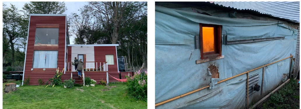
Figura 4. Vivienda 2. Izquierda: fachada sur. Derecha: Fachada norte
