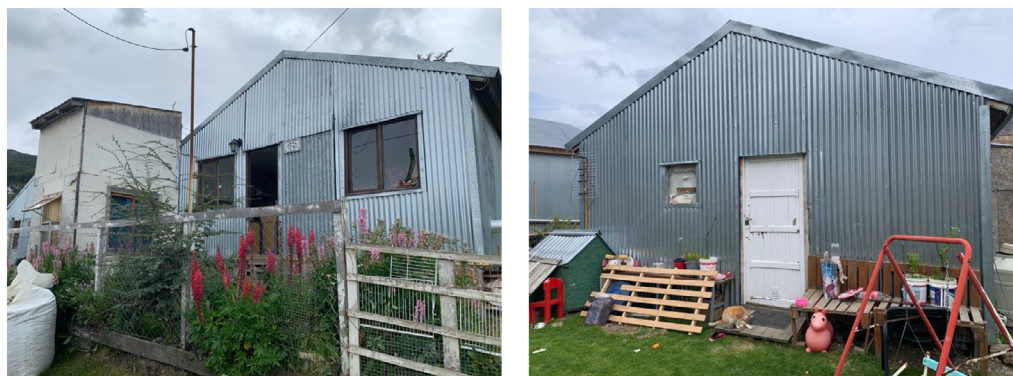
Figura 2. Vivienda I. Izquierda: Fachada sur. Derecha: Fachada norte
