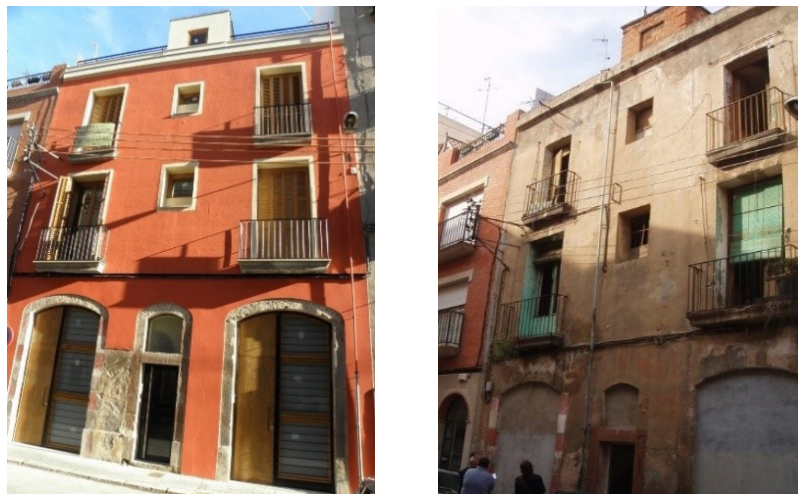
Figura 1. Fotos de la fachada en su situación inicial y final. Fuente: autores
