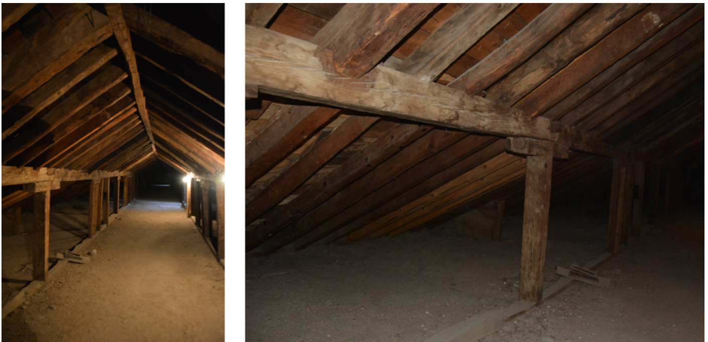
Figura 9. Fotografía de la tipología de par e hilera en el bloque Sur donde se aprecia el apoyo intermedio de viga sobre pilarcillos con zapata y detalle de la unión en barbilla. Elaboración propia.
