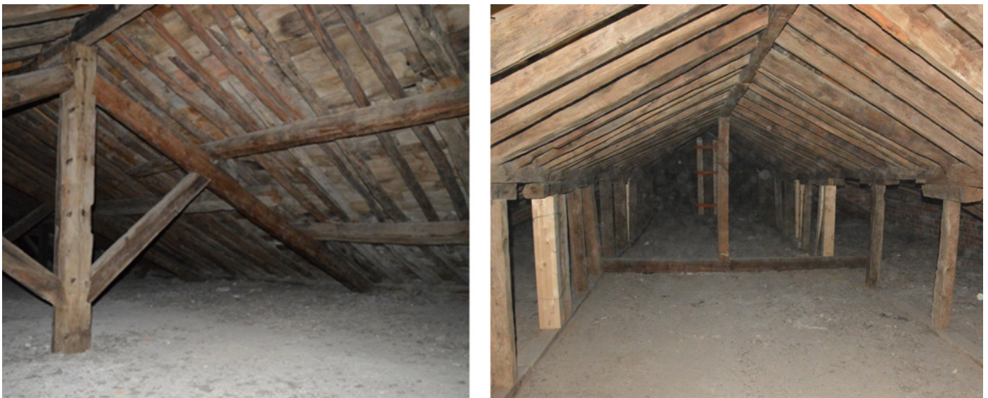
Figura 11. Izda. Vista de la bajocubierta en el brazo Oeste donde se observa el cambio de tipología de cercha española (izquierda) a tipología de par e hilera (derecha). Fuente: Elaboración propia.
