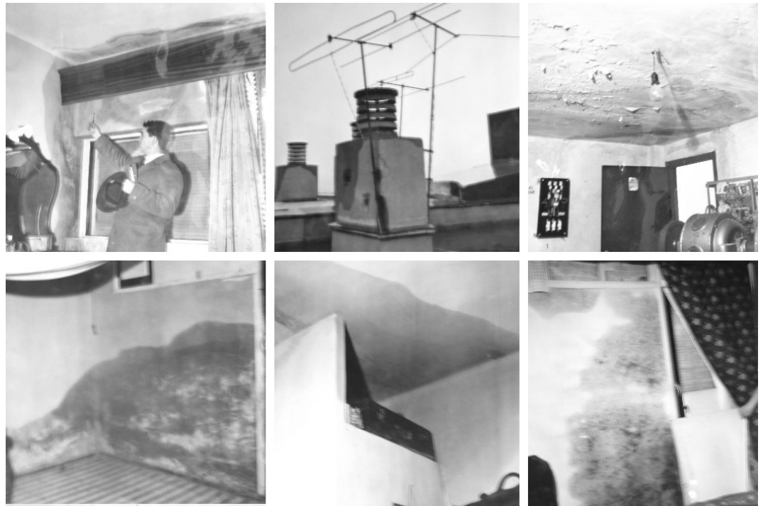
Figura 6. Fotografías recogidas en el dossier de la inspección [46] del Ministerio de la Vivienda sobre el P.D. de Canillas. 1963
