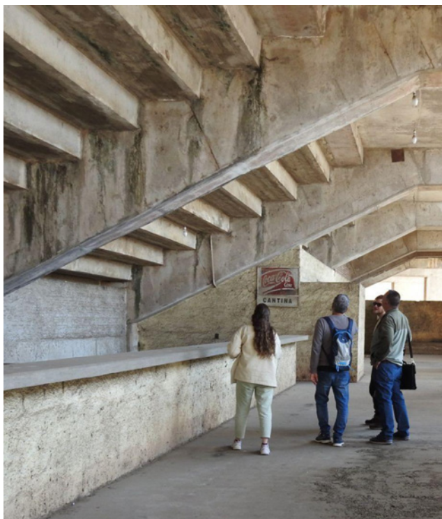
Figura 17. Inspección de elementos estructurales pertenecientes al Estadio
