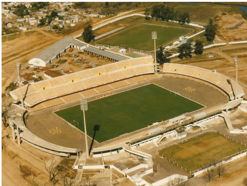
Figura 3. Obras de ampliación finalizadas. Fuente: Ing. Ernesto Lima, 1994
