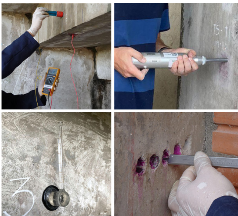
Figura 11. Ensayos realizados in situ
