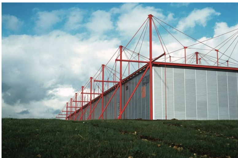
Figura 8. Exterior del edificio donde resalta la estructura reticular. Fuente: Rogers Stirk Harbour + Partners.
