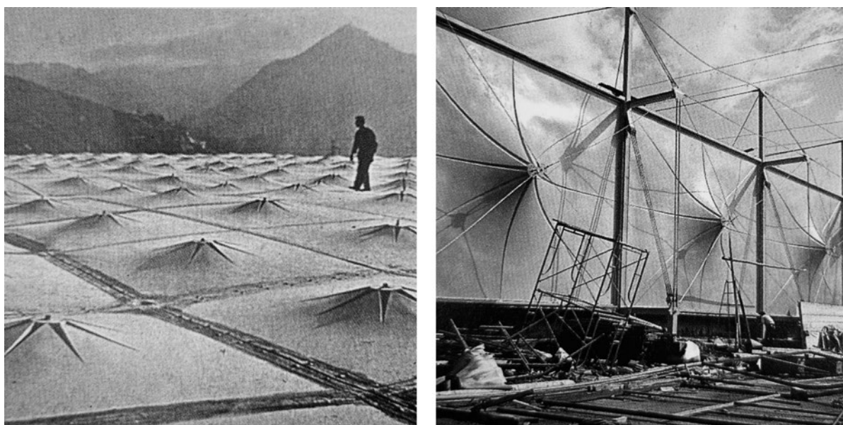
Figura 2. Izq: Estructura de acero tensado y poliéster reforzado, Impresa Ermanno Piano, Génova 1966, Studio Piano. Dcha: Pabellón de la Industria Italiana de la Expo de Osaka en 1970, Studio Piano.
