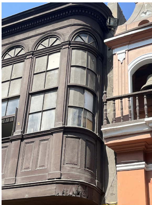
Figura 3. Balcón Republicano en arquería con la curvatura en esquina y el travesaño en el arranque de los arcos. Foto de los autores
