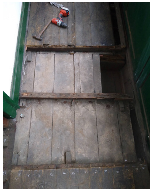
Figura 6. Detalle del doble entablado como resultado de colocar durmientes para enrasar los niveles del balcón con la habitación colindante. Foto de los autores
