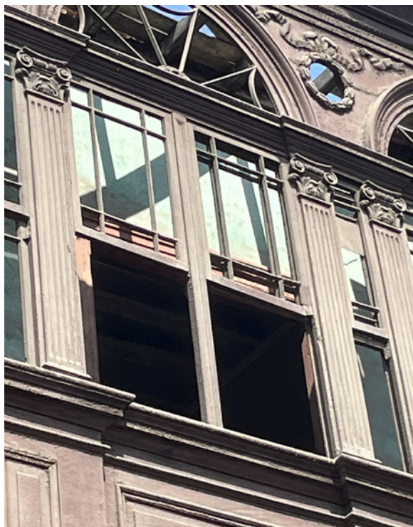
Figura 4. Balcón Republicano en arquería, pero con sectores adintelados entre los arcos. Se observa la acanaladura en el pie derecho para el deslizamiento vertical de las ventanas. Foto de los autores
