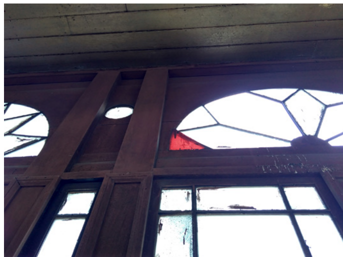
Figura 8. Pies derechos que se une a la solera superior mediante caja y espiga y con el travesaño mediante media madera a la altura del arranque de los arcos. Foto de los autores
