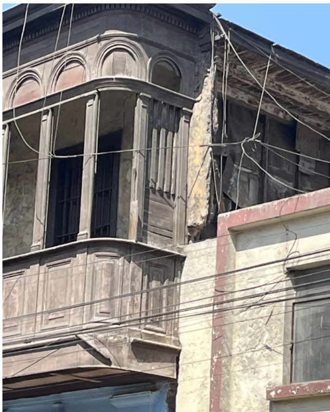
Figura 11. Sujeción de los pies derechos de los balcones con el telar de madera y caña de los pisos superiores. Foto de los autores
