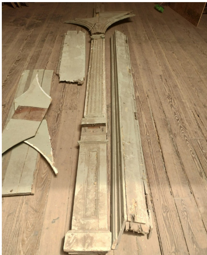
Figura 9. Tablillas molduradas que se colocan sobre los pies derechos. Foto de los autores
