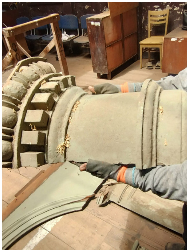
Figura 12. Mascarón de la zona curva que cubre los elementos estructurales en la parte alta del balcón. Foto de los autores
