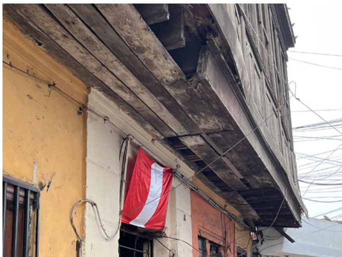
Figura 7. Cerramiento de tabicas y cielos rasos para ocultar los canes de la plataforma de base. Foto de los autores
