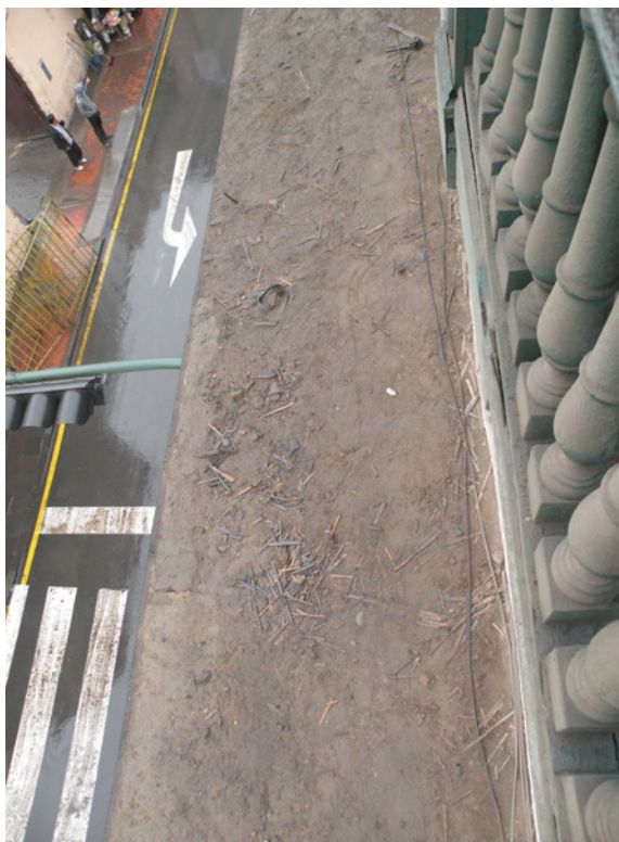
Figura 13. Detalle del terrado colocado sobre el balcón. Foto de los autores
