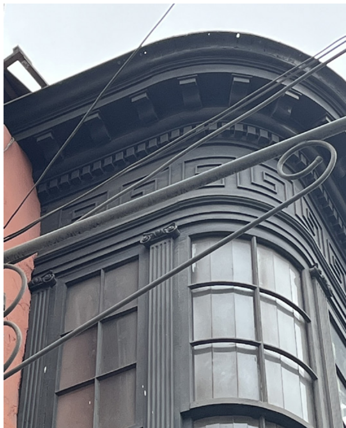
Figura 10. Formación de la curva de esquina con listones de madera y vidrios longitudinales en directriz poligonal. Foto de los autores
