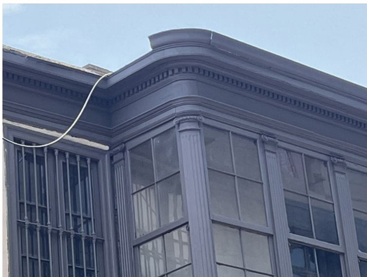
Figura 2. Balcón Republicano adintelado, donde se aprecian las tabicas que conforman el entablamento y el travesaño que marca una línea horizontal en la terminación de los vanos. Foto de los autores
