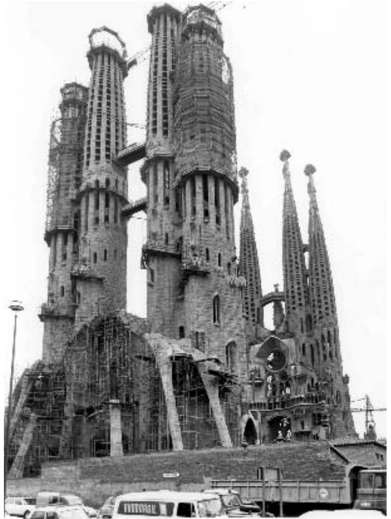
7. Construcción de las columnas de la puerta de la Fachada de la Pasión. Fuente: ATESF.
