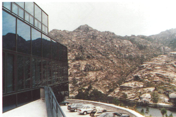
Asentamiento del edificio.
