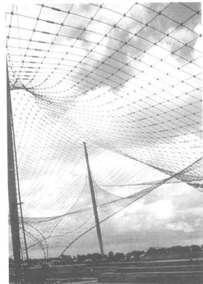
Figura 19.- Pabellón alemán en Montreal (1967). Frei Otto y Rolf Gutbrod. Utiliza una malla de cables de acero de 12 mm separados entre sí 50 cm. Toda la cubierta fue diseñada sobre modelo, tanto para la comprobación tensional como para el corte de los cables de la red. La solución que da Frei Otto al problema de la unión de la red con el pilar es formidable. Crea un bucle resistente que sale de la cabeza del pilar y del cual cuelgan los elementos de la red.
