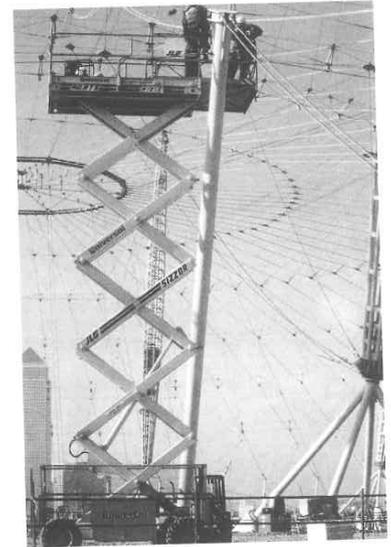
Interior de la cúpula en la que se aprecian las torres de sustentación, los cables meridianos y el atirantamiento interior y exterior.
